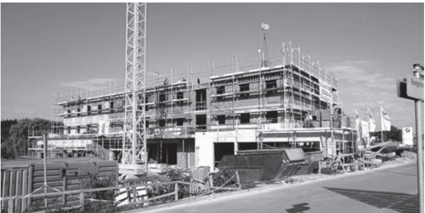
Die Fassade von der Nord-West-Seite - als Planungskizze - und der Rohbau aus der Süd-West-Seite Anfang Juli 2013.
